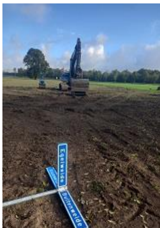
Bunderse hoek wordt bouwrijp gemaakt
